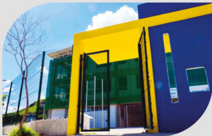
PORTÃO DE PEDESTRE
